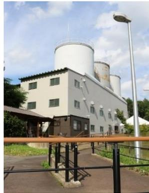
揚水した湯川の水に石灰石粉を混ぜ合わせる「草津中和工場」
