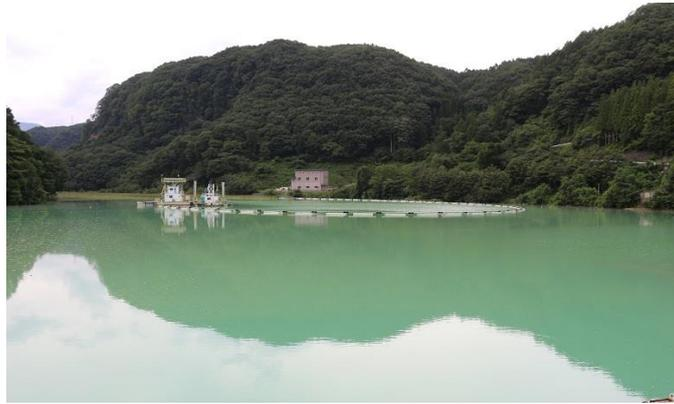
酸性水の中和でできる“中和生成物”を沈殿・貯留する品木ダム
