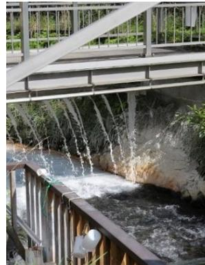
石灰石粉を混ぜた石灰混合水を湯川に戻す
