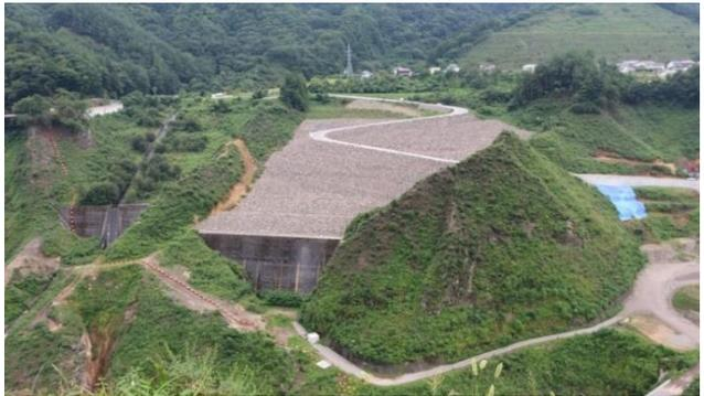
ハツ場ダム左岸側にある「やんば見放台」からは、ダム堤体上流側が目前。天端中央に「非常用洪水吐」。その下の3つの四角い穴は、下2つが「常用洪水吐」。上が「水位維持用放流設備」。目を転じると右岸側高台に代替地が連なる
