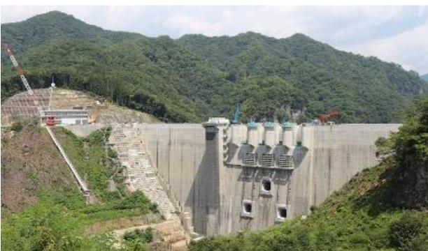
ハッ場ダムの堤高116m、総貯水容量1億750万t。洪水調節容量6500万t。大雨時にはこの大きな水瓶が効果を発揮する
