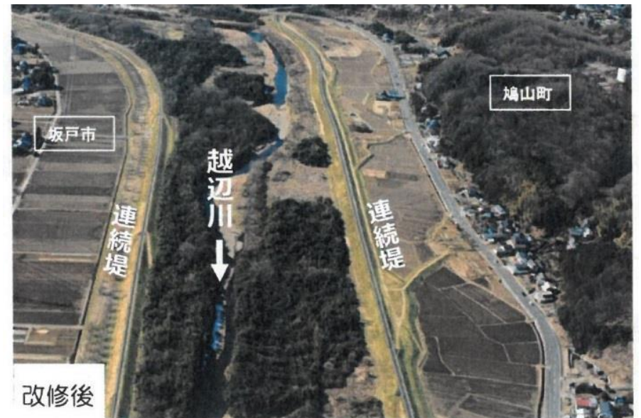
荒川の支川、越辺川の改修後の連続堤
